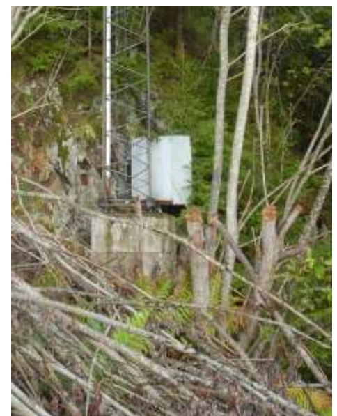
Koblingskap skal skiftes ut
